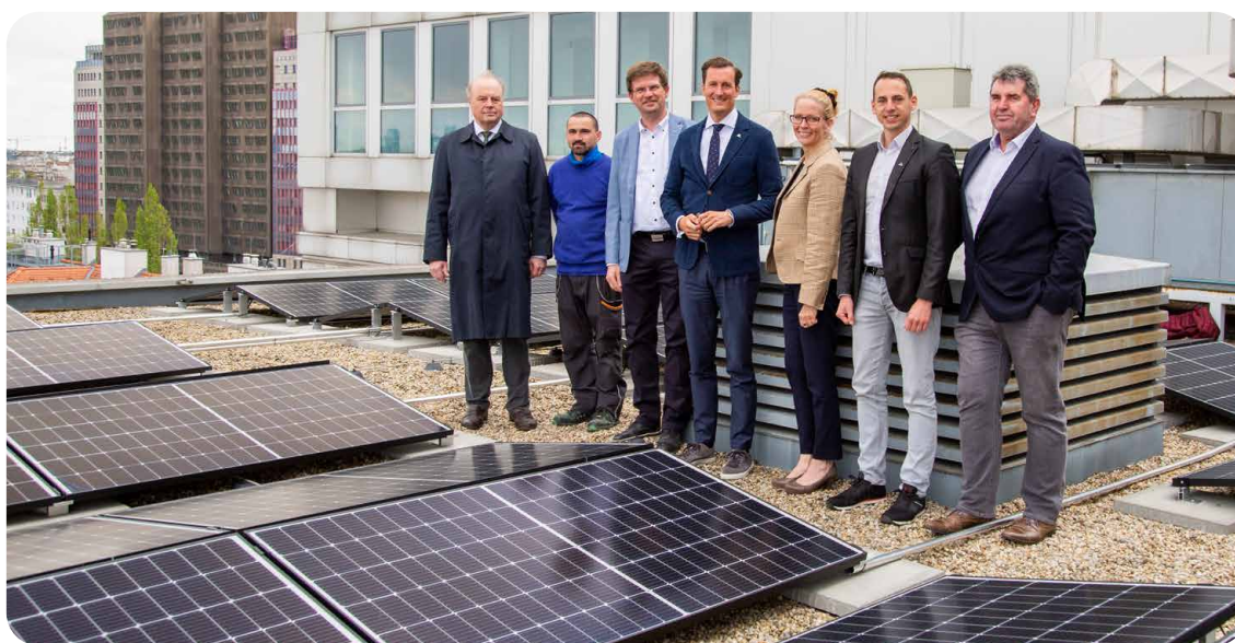
Bernhard Spitaler (3. von links), Wolf Gerlach (Mitte), Andrea Sternberg (3. von rechts), Stephan Neuberger (2. von rechts) und Ernst Beizer (ganz rechts) bei einer Begehung anlässlich der Montage der neuen Photovoltaikanlage im Wiener Headquarter mit Vertretern der ausführenden Firma. Die Anlage erzeugt 100.000 kWh Sonnenstrom pro Jahr und spart damit 21 Tonnen CO 2 ein.
